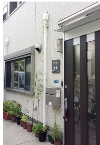
住宅街になじむ落ち着いた外観
